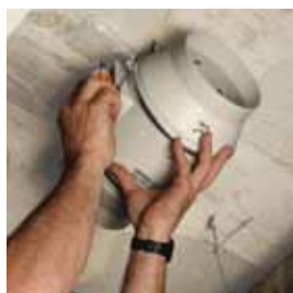
Colocar el cuerpo motor.
