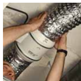
Acoplar los conductos.
